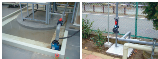
防液堤の設置(開発研究所)
