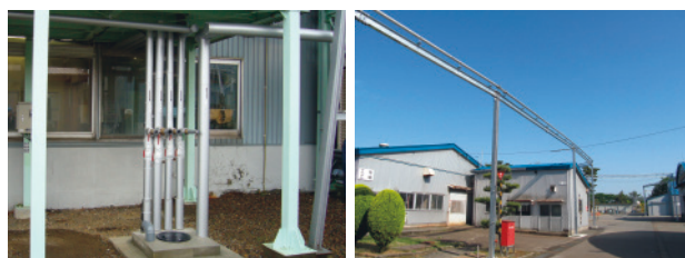
埋設配管の地上化(北海道工場)
