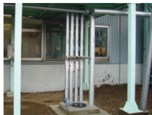
埋設配管の地上化(北海道工場)
