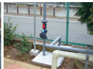
埋設配管の地上化(開発研究所)
