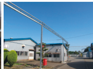
埋設配管の地上化(新潟工場)
