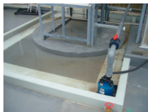
防液堤の設置(開発研究所)
