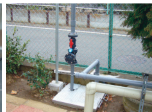
埋設配管の地上化(開発研究所)
