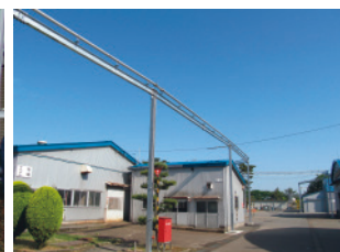
埋設配管の地上化(新潟工場)
