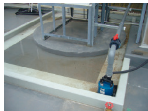
防液堤の設置(開発研究所)
