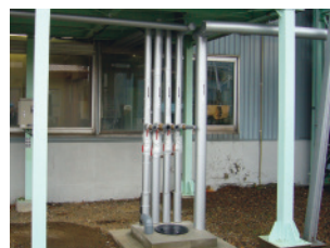
埋設配管の地上化(北海道工場)
