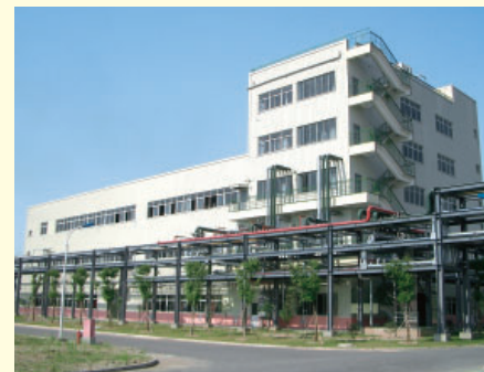
張家港北興化工有限公司 新プラント
