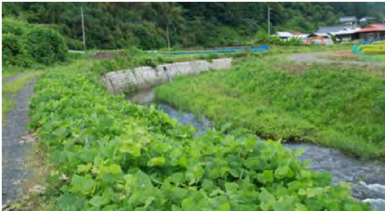
写真③ 河川の のり面(のり面にはクズが繁茂)
