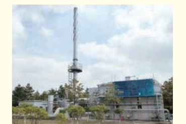
蓄熱燃焼式排ガス処理設備
