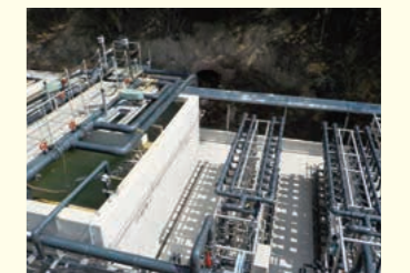
排水処理設備
