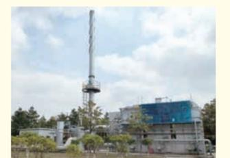
蓄熱燃焼式排ガス処理設備
