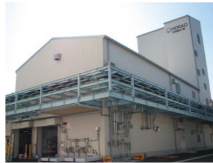
岡山工場合成第9工場外観
