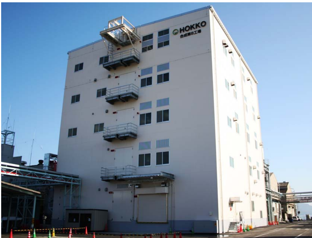
〈合成第8工場の外観〉
