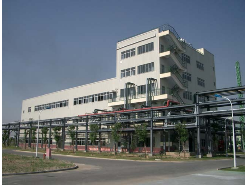
今回完成した新プラント
