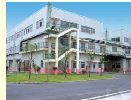
張家港北興化工有限公司 第2工場
